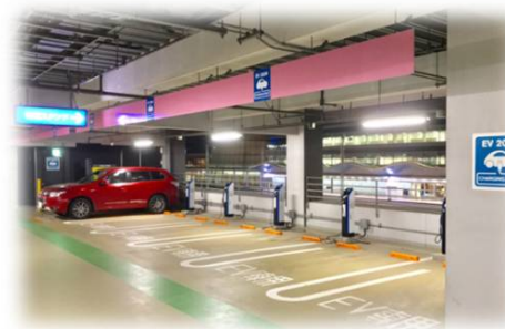
電気自動車充電スタンドの設置
