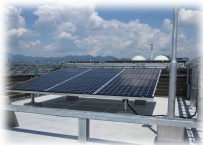
屋上階にソーラーパネルを設置
